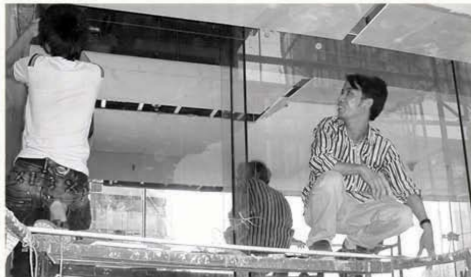
Chăm chú quan sát thợ thi công
