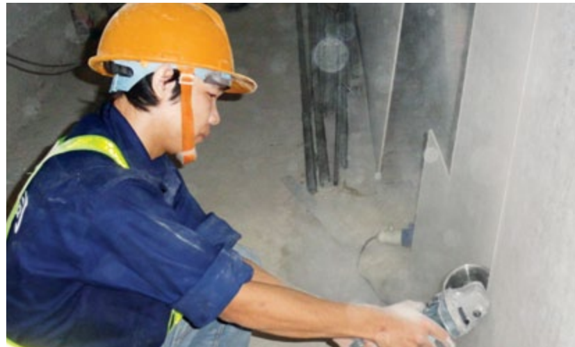
▲ Cắt tấm calcium silicate DURAflex 6mm để lắp vào vị trí còn thiếu.
