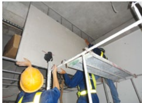
▲ Đưa tấm calcium silicate DURAflex vào vị trí trần cần lắp đặt.
