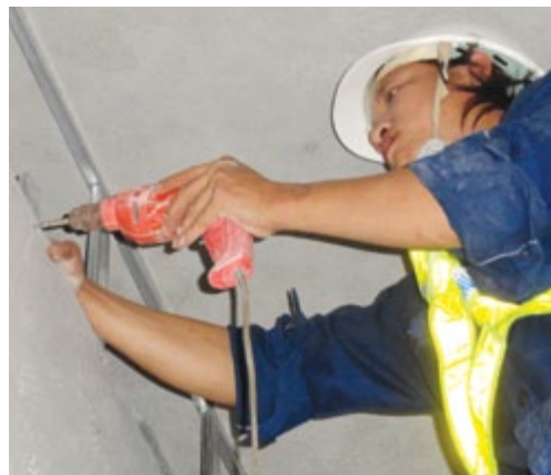
▲ Tiếp đó bắt vít cố định tấm trần vào đúng vị trí. Thao tác này cần đòi hỏi sự tỉ mỉ, cẩn thận để “ăn” ngay trong lần bắt vít đầu tiên
