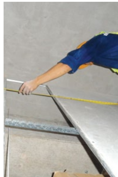
▲ Nếu còn thiếu, người thợ sẽ phải đo kích thước vị trí còn thiếu để cắt tấm cho vị trí này
