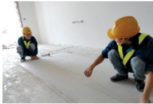
▲ Các anh công nhân đang bung mực lấy dấu trên tấm Calcium silicate DURAflex 6mm.
