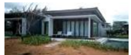
▲ Hiện dự án đang trong quá trình thi công. Tấm DURAFlex 8mm và hệ khung BASI được sử dụng làm trần cho hành lang và ban công toàn dự án
