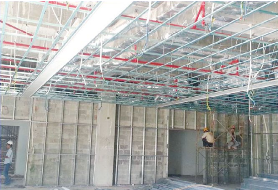
▼ Thợ thi công đang thi công công trình Trung tâm hành chính Tp. Đà Nẵng
