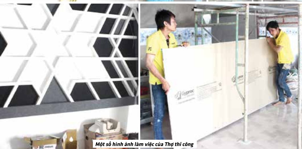
Một số hình ảnh làm việc của Thợ thi công
