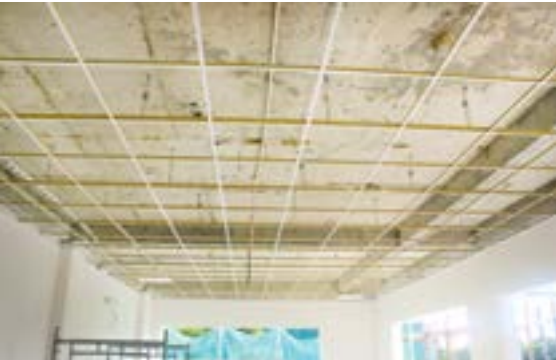
Trần nổi sử dụng Khung trần nổi Vĩnh Tường FineLINE Plus và tấm trang trí Vĩnh Tường hoa văn Bamboo cho khu vực nhà kho.
