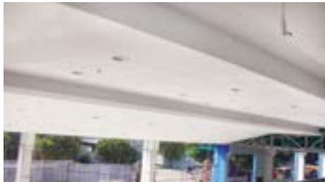
Trần nổi sử dụng Khung trần nổi Vĩnh Tường FineLINE Plus và tấm trang trí Vĩnh Tường hoa văn Bamboo cho khu vực nhà kho.
