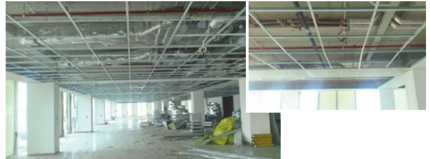
▲ Hiện trạng công trình với các loại khung và tấm đang thi công.
