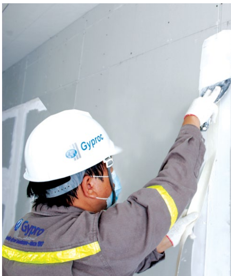
▲ Xử lý khe nối vách thạch cao bằng bột Gyp-Filler
