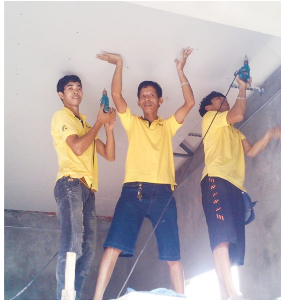
▲ Thợ thi công của Cửa hàng Thành Vững đang thi công công trình
