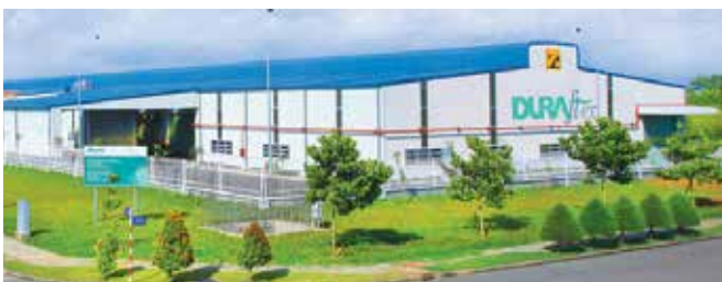
Nhà máy Hiệp Phú được xây dựng tại KCN Long Hậu, tỉnh Long An. Đây là nhà máy chuyên sản xuất tấm Calcium Silicat DURAflex. Công suất ước tính đạt gần 20 triệu mét vuông mỗi năm.
