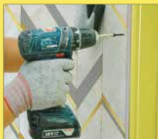
Bắn vít* tự khoan giữa 2 tấm và dán keo giữa tấm ốp tường
